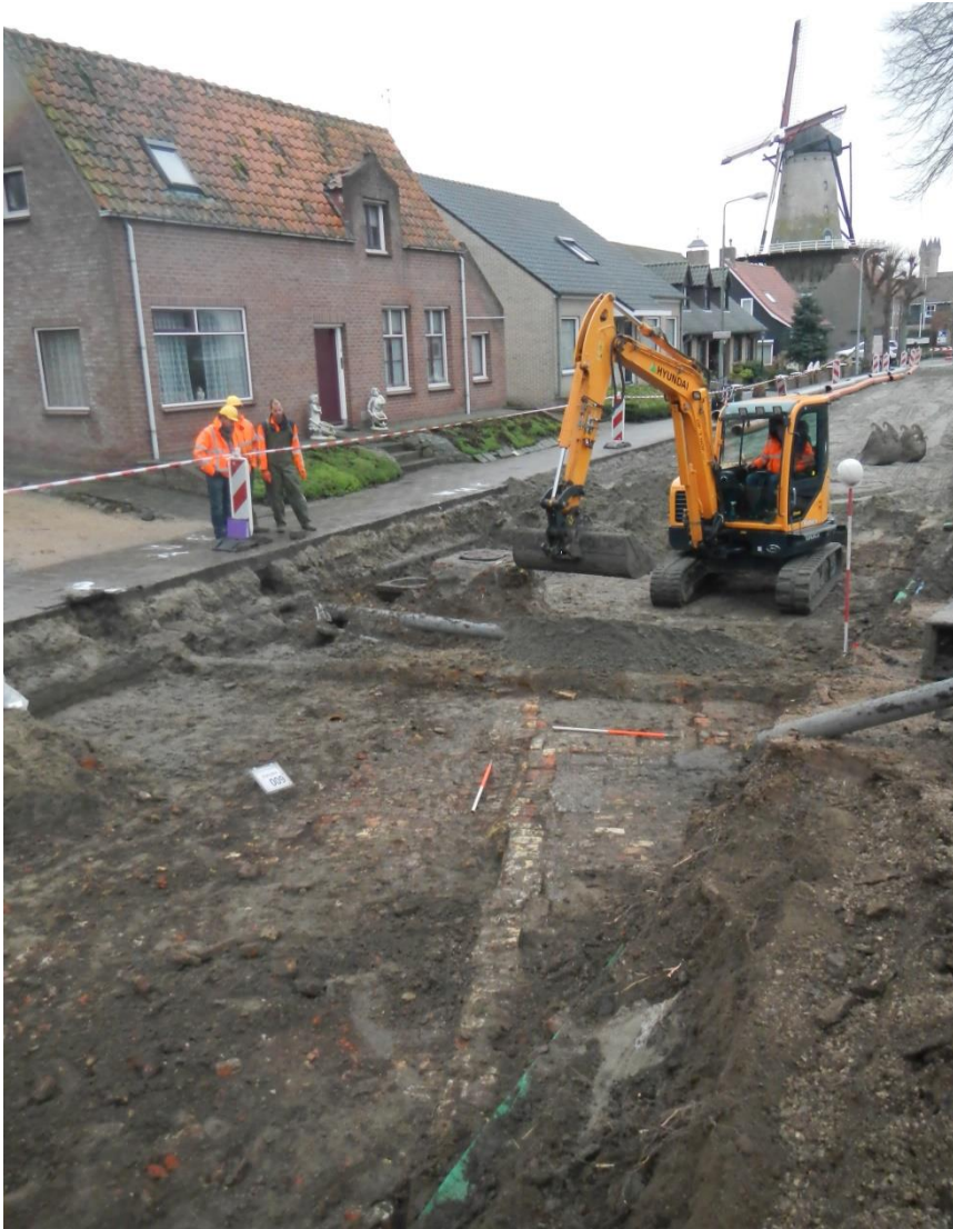
Afbeelding 23 Zicht vanuit het zuidoosten op de funderingsresten (sporen 11 tot en met 19) in vlak 1.
