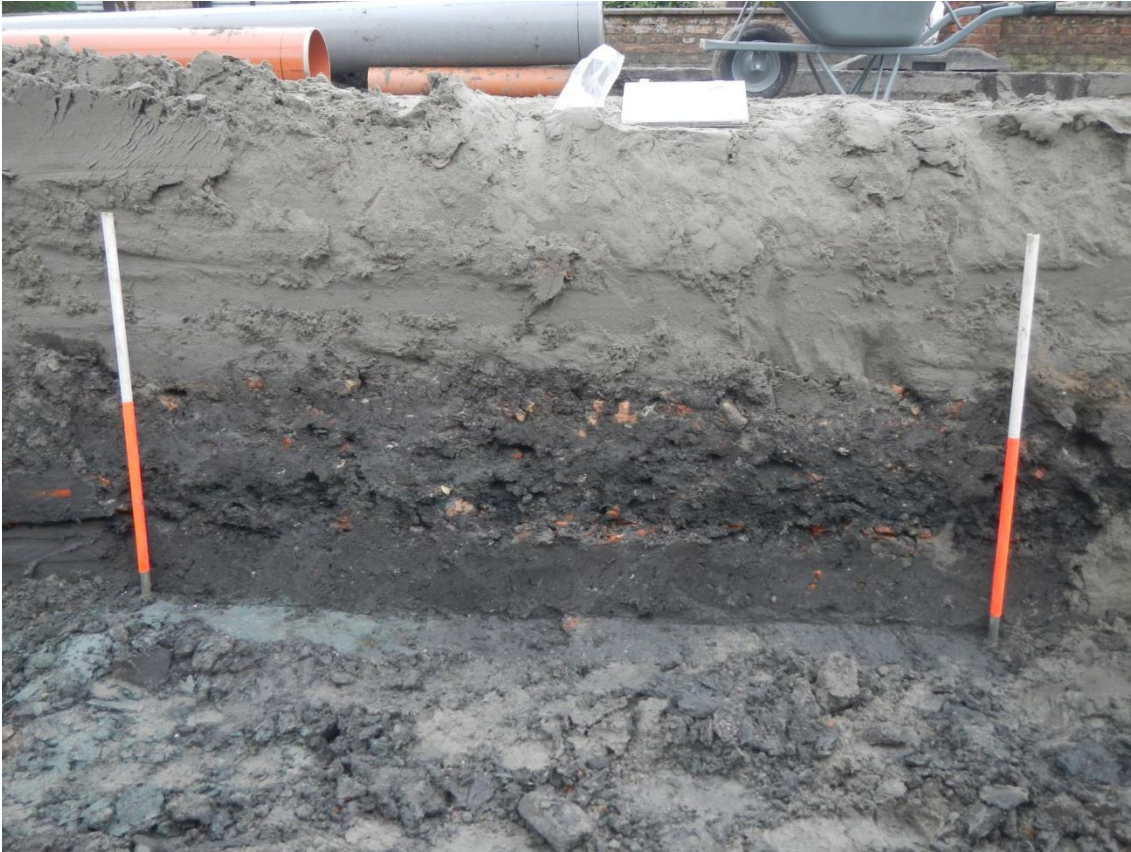
Afbeelding 15 Zicht vanuit het noordoosten op profiel 4 in de rioleringsleuf (vlak 2). De bovenste helft van het bodemprofiel bestaat uit recent bouwzand, aangebracht na het ontgraven van het wegcunet. Onder een puinhoudend ophoogpakket bevindt zich een humeuze, kleiige cultuurlaag met puinbrokjes. Links in het vlak zijn de onderliggende, blauwgrijze, natuurlijke afzettingen van het Laagpakket van Walcheren zichtbaar.
